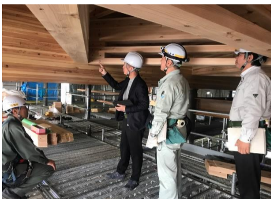
【特別棟】木軸建方完了時の監理者検査を行いました。
