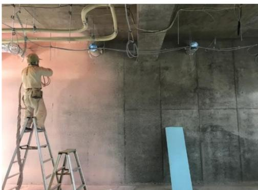
【管理棟】内部の断熱材を吹き付けています。
