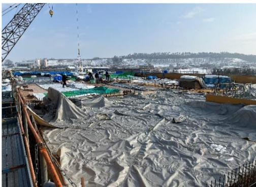
【校舎棟】躯体の型枠を組立てた場所は除雪用シートで養生します。
