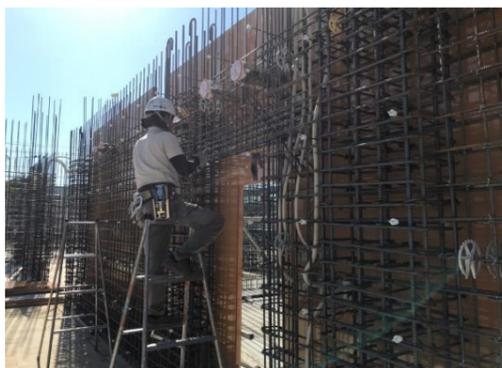
【校舎棟】上部躯体（現在は1階）の鉄筋と型枠を組立っています。
